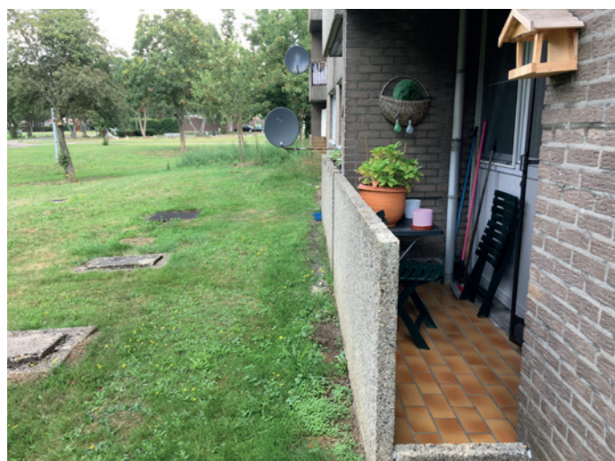
Te klein terras bij appartement (zijkant opengebroken)
