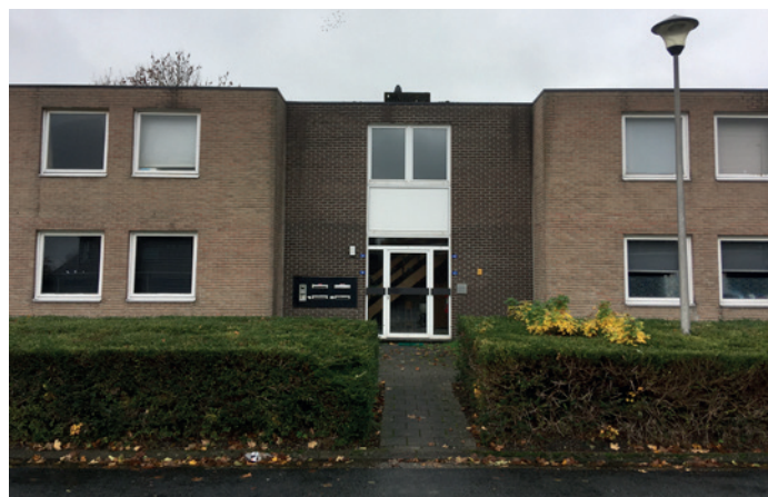
Bestaande appartementen in Schoonbeek
