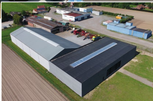
Project Moerbeke-Waas uitvoerder Ferket Dakwerken
