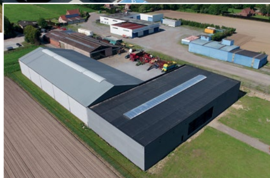
Project Moerbeke-Waas uitvoerder Ferket Dakwerken
