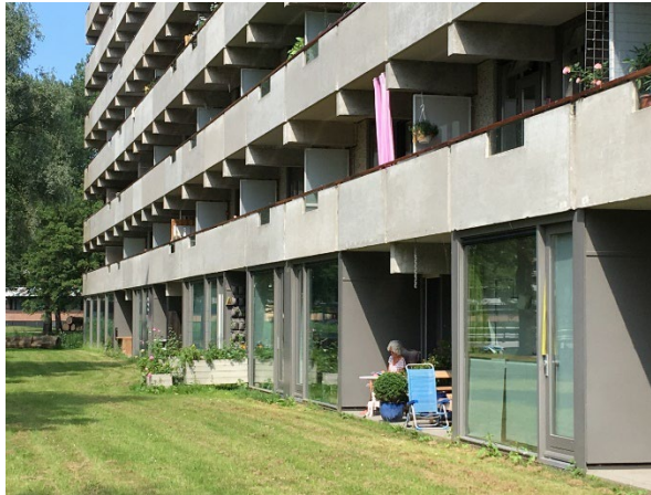
Kleiburgflat - achtergevel en fietsenstalling
