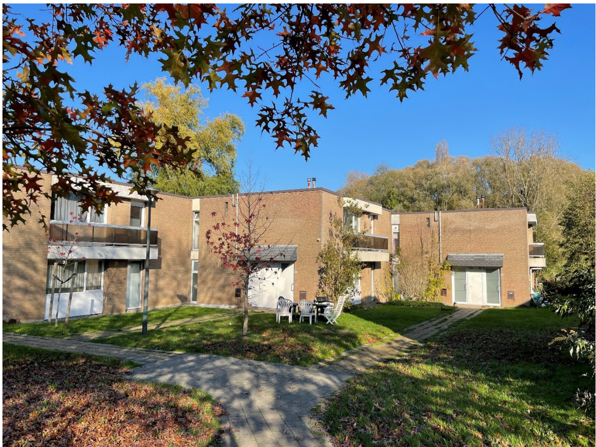
Oppem – Geschakelde woningen in de wijk
