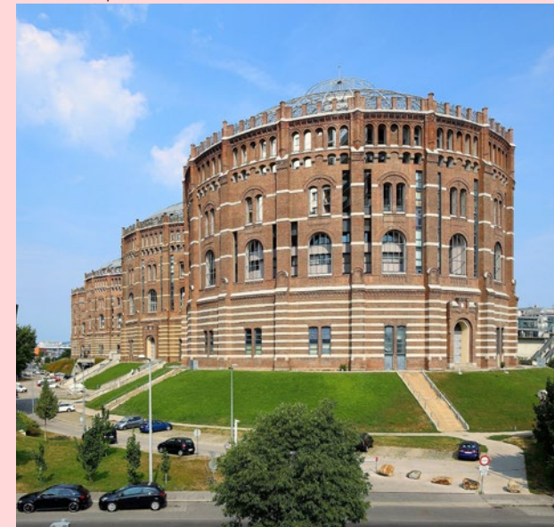
Gasometer A, Jean Nouvel
