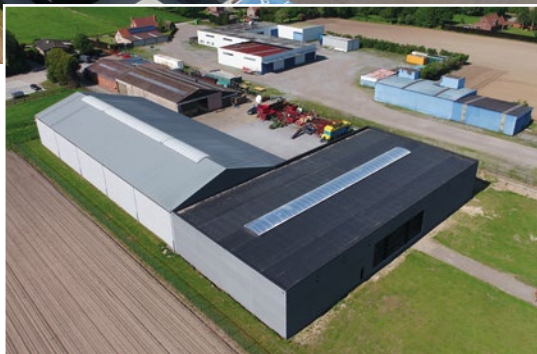
Project Moerbeke-Waas uitvoerder Ferket Dakwerken
