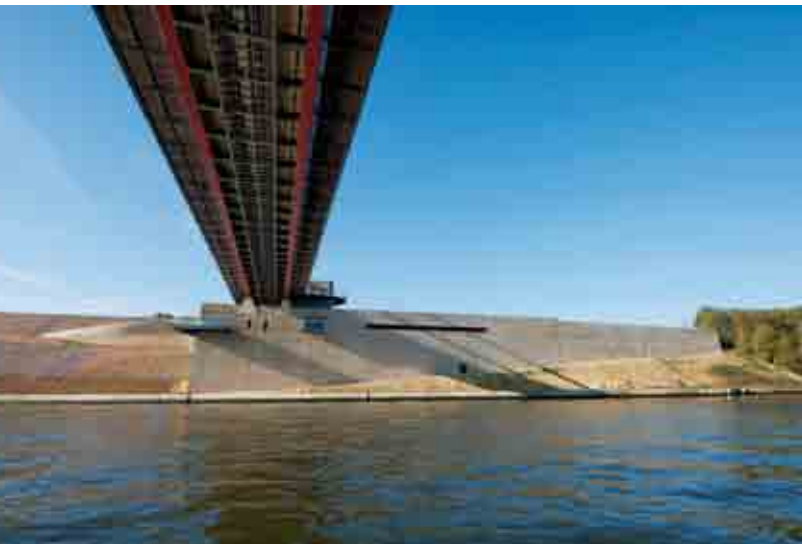
Ney + Partners: Brug over Albertkanaal, Vroenhoven
